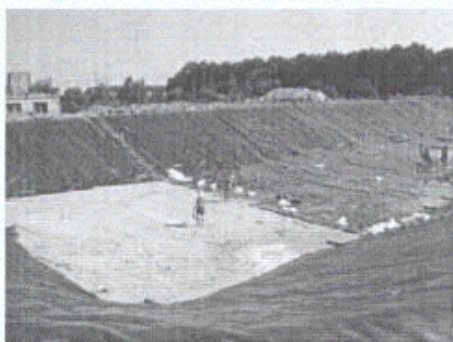
Монтаж геомембраны (пример).
